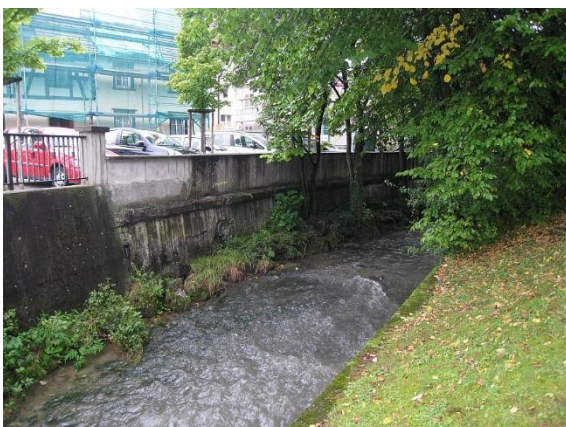
GF 26: Verbaute Scherzach im Bereich Ochsen-gasse/Scherzachstraße. Angrenzend kleine Grünanlage.
