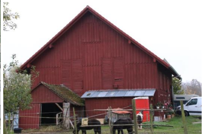
Abbildung 2: Scheune (Pferdegnadenhof), Bereich Welte, Weingarten. Foto vom 11.11.2019, Ramos.
