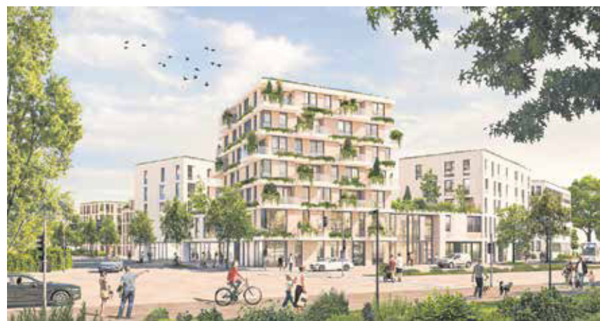
Markant und doch filigran wirkt das Gebäude an der Ecke Ravensburger / Moosbruggerstraße.
